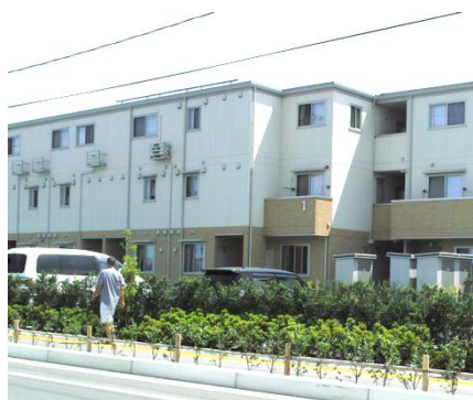
入居が始まった災害公営住宅の1つ
