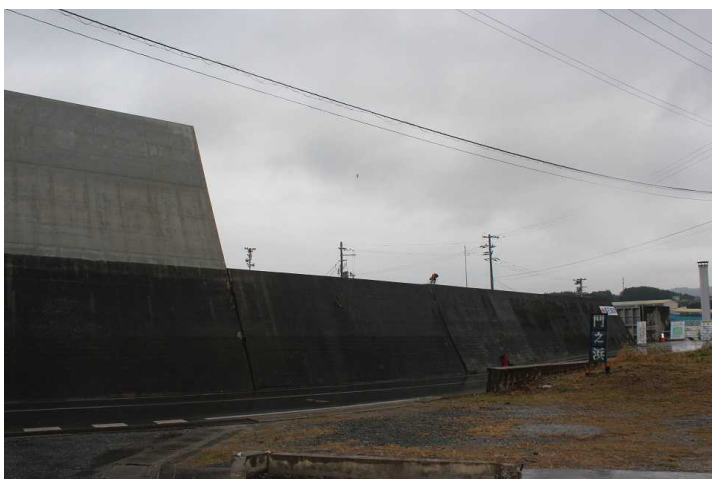
護岸工事が異様な光景をつくり出していた（色の濃い部分がもとの防波堤の高さ。倍以上の高さに積み上げられ、風景を遮断していた）
