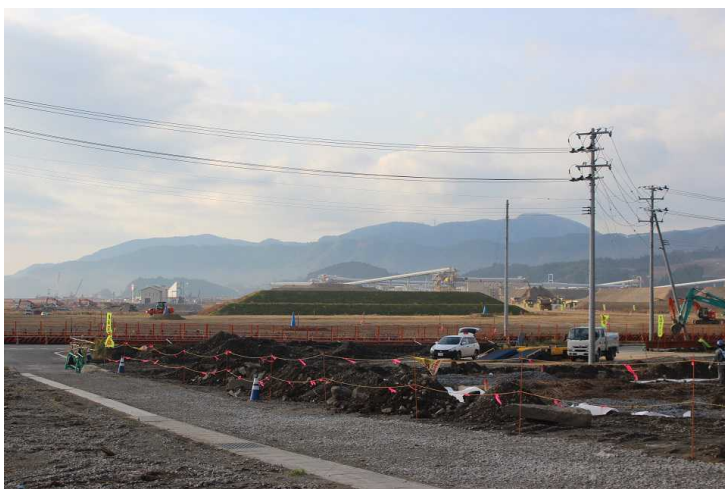
朝7時から轟音とともに什器が稼動。かさ上げ工事が進む
