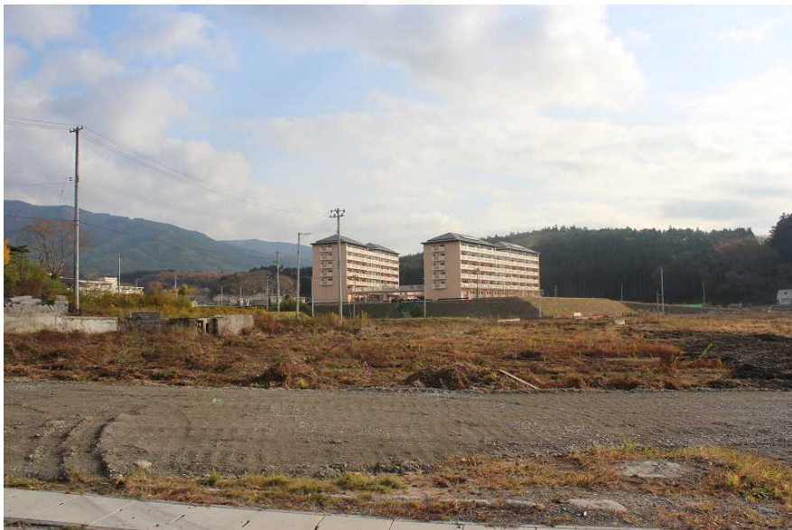
市内初の災害公営住宅。更地となった一角に建ち、すでに入居が始まっている。陸前高田市は未だ全ての仮設住宅が残る
