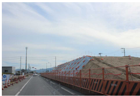
石巻でもかさ上げ工事が続く
