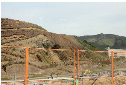
至るところで続かさ上げ工事は 町の自然も大きく変えている
