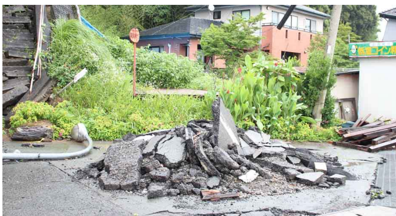
隆起し激しく割れたコンクリートが揺れの大きさを物語る
