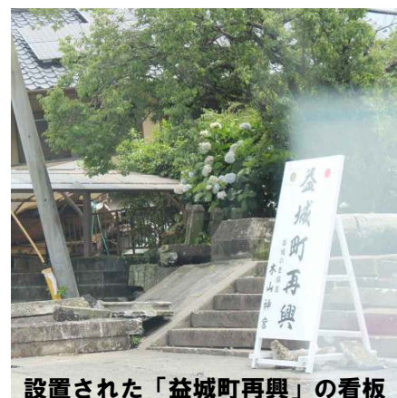
隆起し激しく割れたコンクリートが揺れの大きさを物語る
