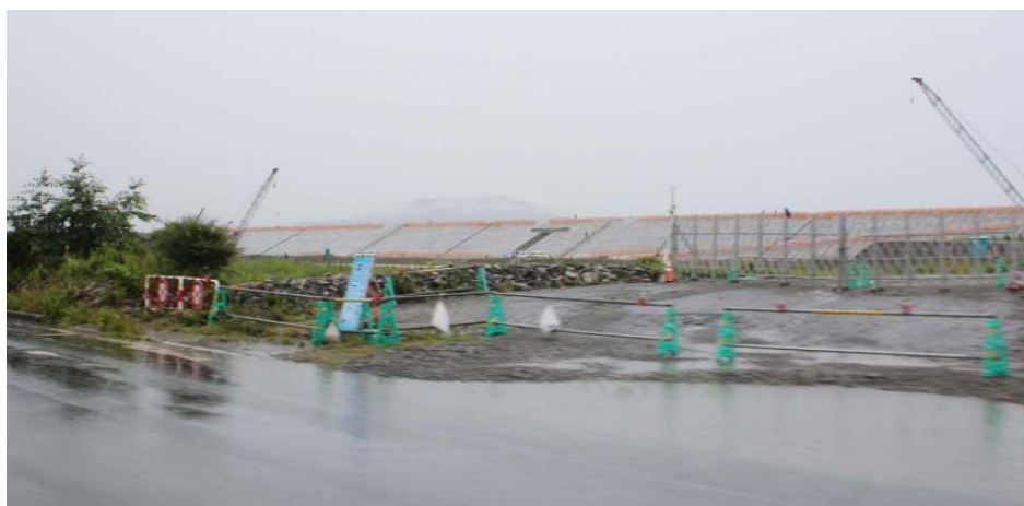
海を囲うように防波堤の建設が進められ、道路から海は見えなくなった。
