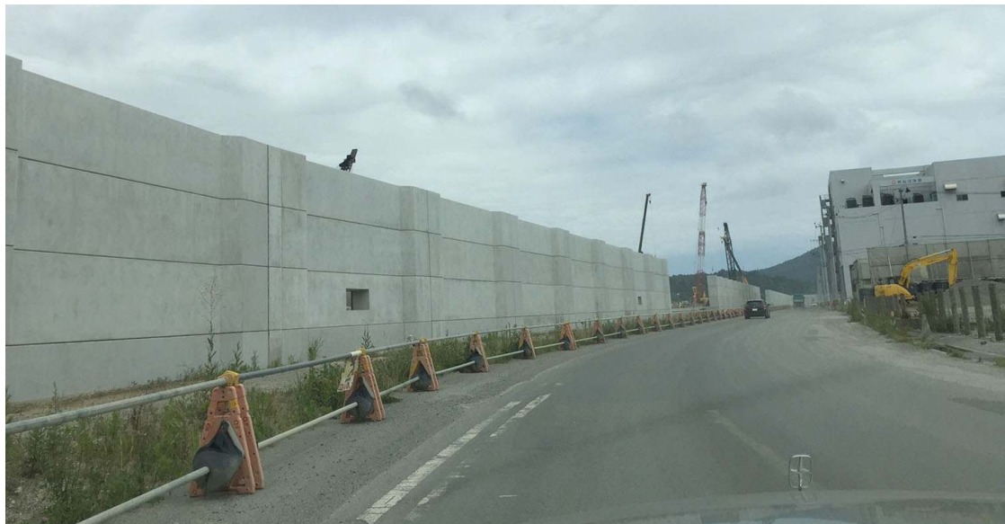
道路に沿って防波堤の建設が進められていた。
