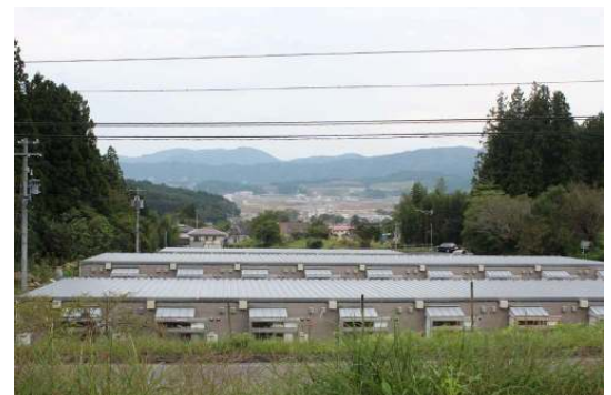
公営住宅への移行が進む中、多くの仮設住宅も残り、長期的な使用が可能な仮設住宅への集約が進められ、全戸退去となった住宅から解体作業が進められる見通し。
